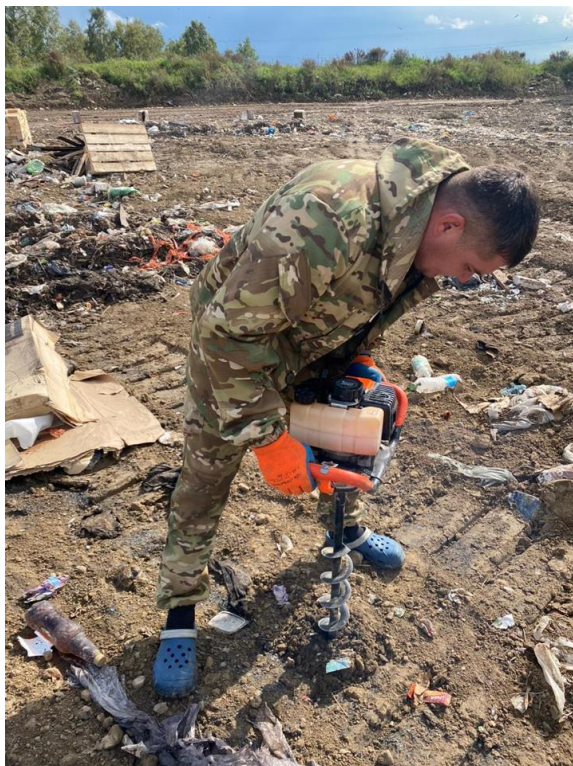
Рисунок 4. Бурение шпуровой скважины
